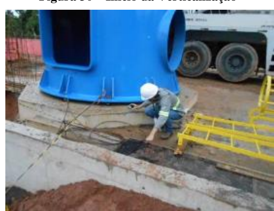
Figura 32 – Conferência da Verticalização
