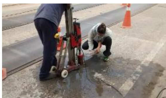
Figura 11: Extração de Corpo de Prova na Ponte
