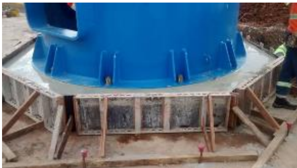
Figura 33 – Detalhe da base do RHO antes de grouteada
