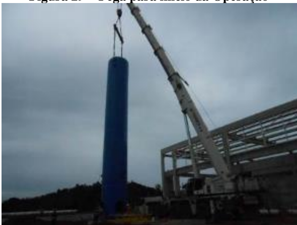
Figura 31 – RHO Verticalizado
