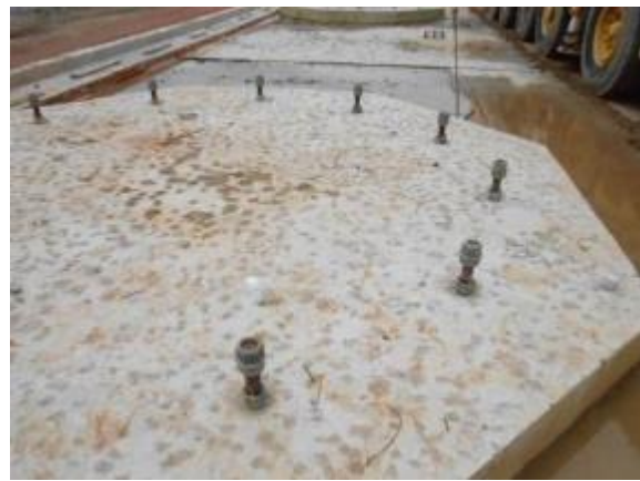
Figura 22 : Detalhe das Bases antes da concretagem e após a concretagem
