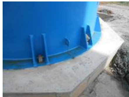
Figura 34-Detalhe da base do RHO depois de grouteada
