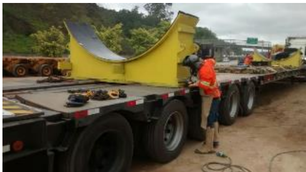
Figura 6 – Carreta de transporte
